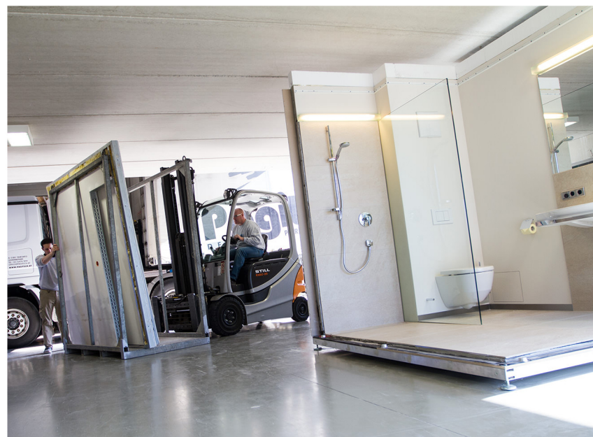
V 1. Module werden direkt vor Ort aufgebaut
